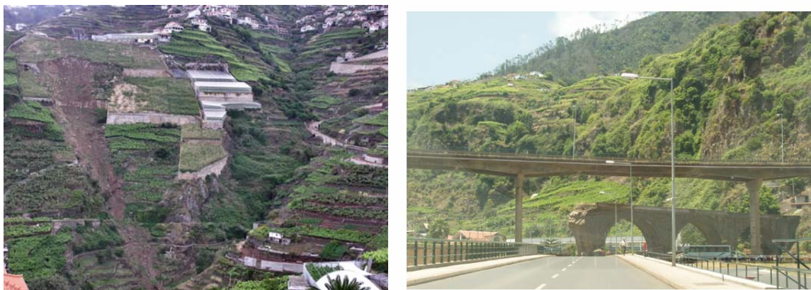
Fig. 4: Deslizamiento de tierras en el sur de Madeira y puentes de la Ribeira de Faial, en el norte de la isla. El antiguo fue destruido por el agua en marzo de 1984 tras una racha lluviosa de 18 días y un total de 845, 1 mm; tres de los días registraron una intensidad > a 100 mm.
