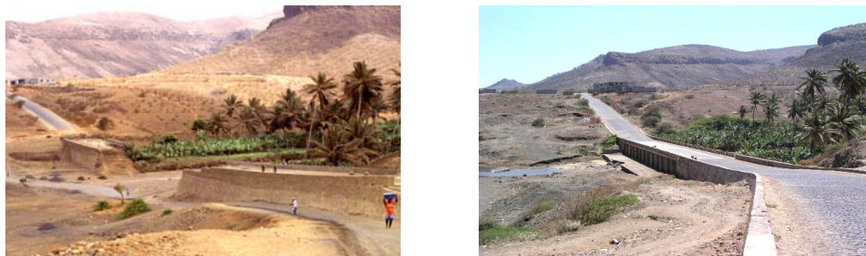
Fig. 5: Imágenes obtenidas en julio de 1995 y marzo de 2005 de un puente en el SE de Santiago (Cabo Verde) arrastrado por las aguas y vuelto a levantar años más tarde.
