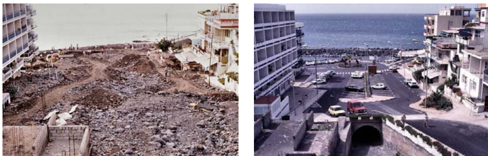
Fig. 7: El 7 de abril de 1977 una tromba de agua ( 344,5 \text{ l/m}^2 ) sobre el NE de Tenerife hizo que el bco. de San Juan, con una cuenca de 1,04 \text{ km}^2 y un cauce de sólo 2,7 \text{ km} de longitud con un 28% de desnivel, arrastrara más de 40.000 \text{ m}^3 de material. Las imágenes muestran que las soluciones dadas a su desembocadura incrementan su vulnerabilidad ante un próximo paroxismo pluviométrico
